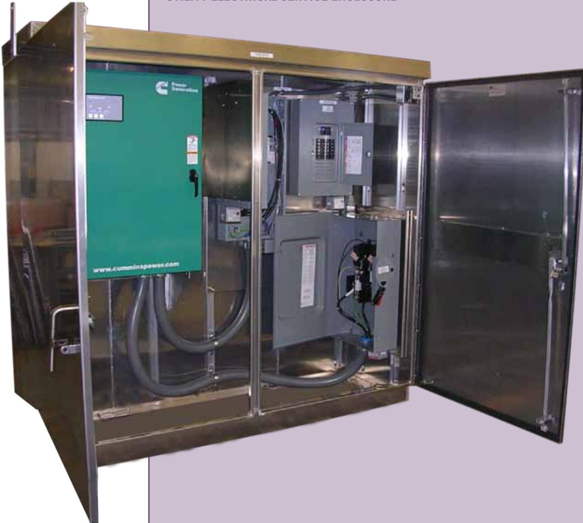
**PUMP CONTROL AND BACK FLOW VALVE ENCLOSURES**
